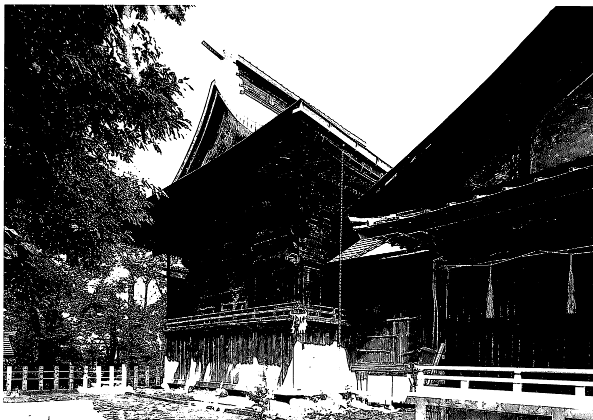
4 修理前 正側面（南西より）
