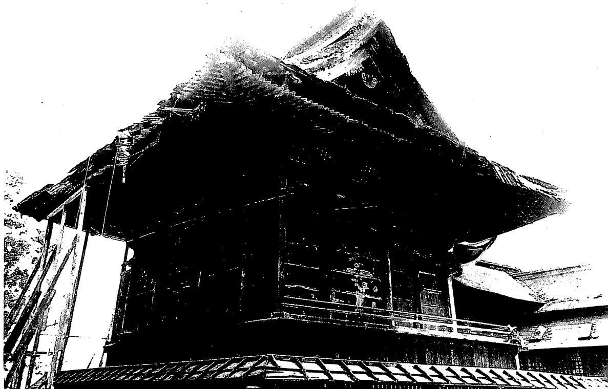
6 昭和57年屋根鉄板覆い前 背側面（北西より）
