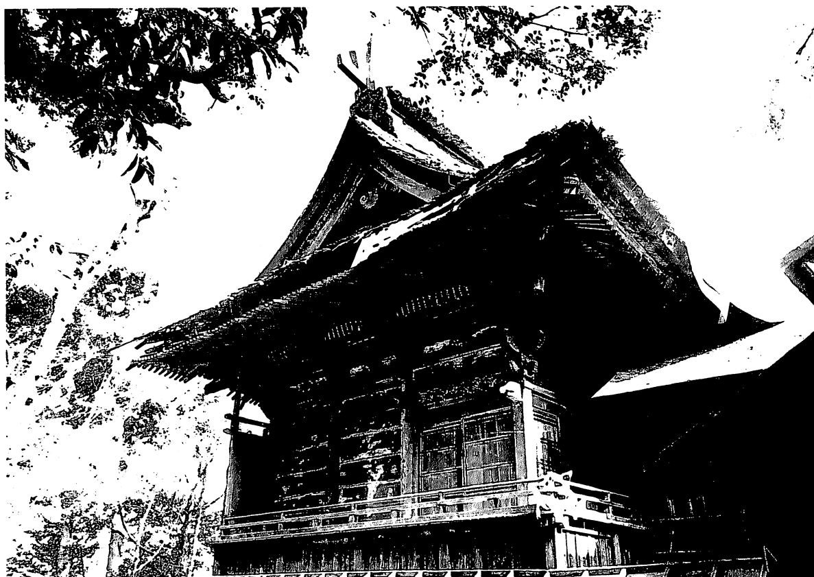
5 昭和57年屋根鉄板覆い前 正側面（南西より）
