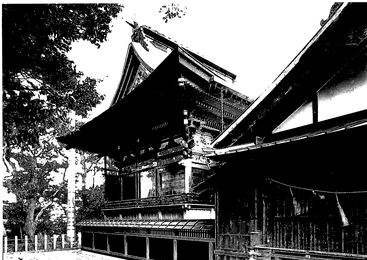
3 竣工 正側面（南西より）
