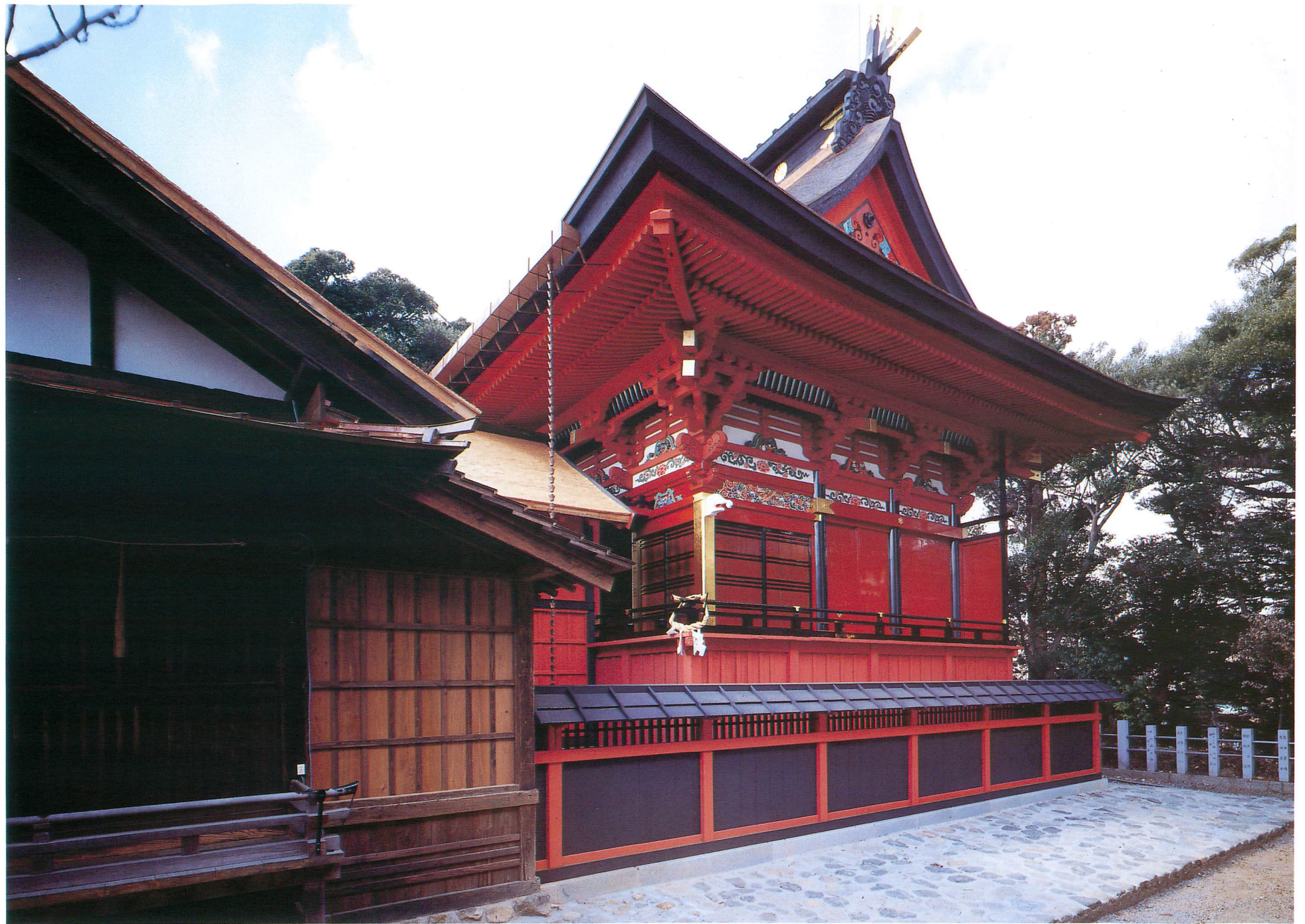
1 竣工 正側面（南東より）
