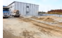
鹿島中仮設校舎に特別教育用 仮設校舎増設 (平成25年3月27日)
