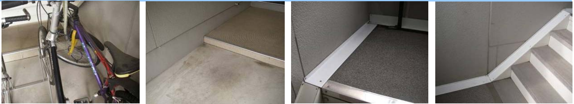
B棟階段部分 整備後
