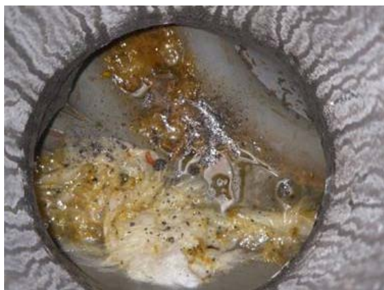
排水桝内部の汚れ状況
