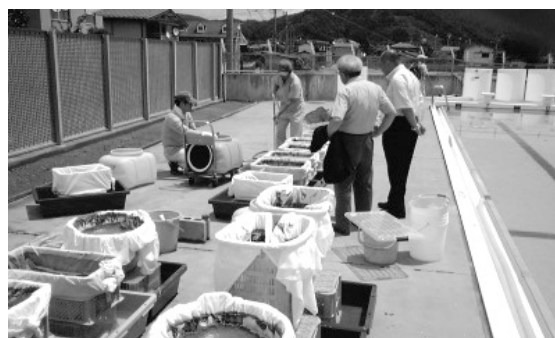
写真-1 福島大学付属中学校プールの除染風景
